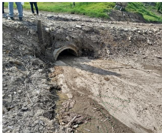
Foto 6. Obra transversal 2 en vía existente.
