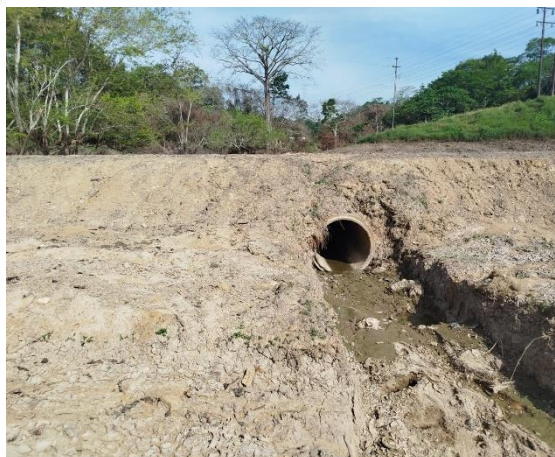
Foto 5. Obra transversal 1 en vía existente.
