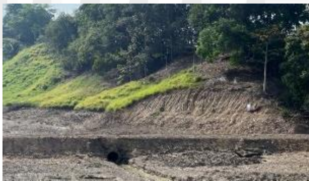
Foto 3 y 4. Talud expuesto conformado por la adecuación de vía veredal existente.
